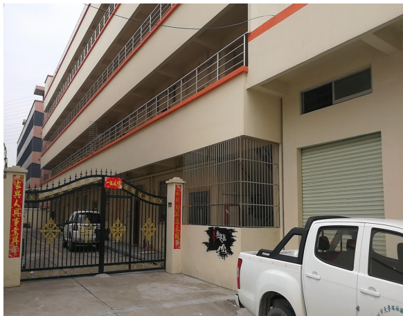
项目西南面工人宿舍
