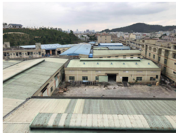
项目西面其他厂房
