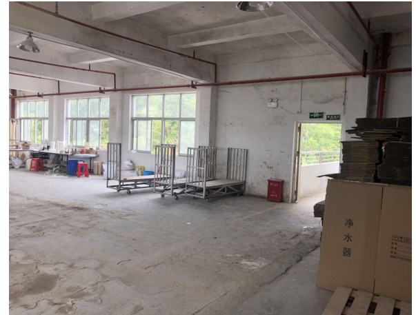
项目车间现状
