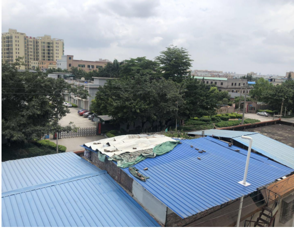
项目东面工业厂房
