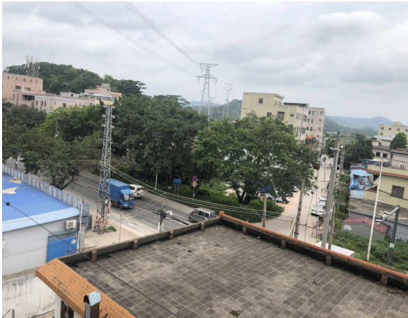
项目北面工业厂房
