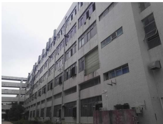
项目北面工业厂房
