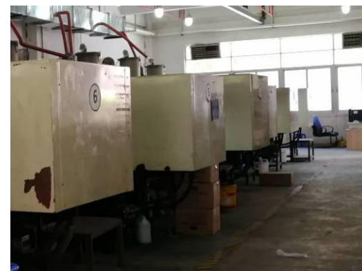
项目车间现状
