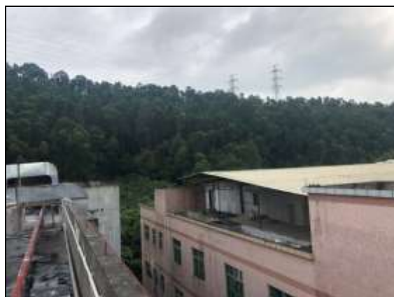
项目北面工业厂房
