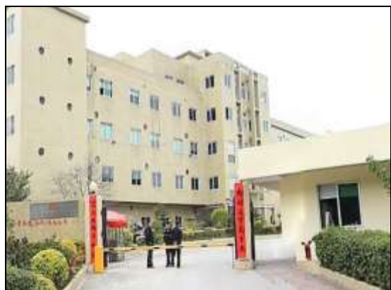
项目北面工业厂房
