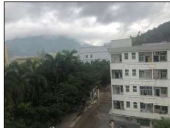
项目西面工人宿舍
