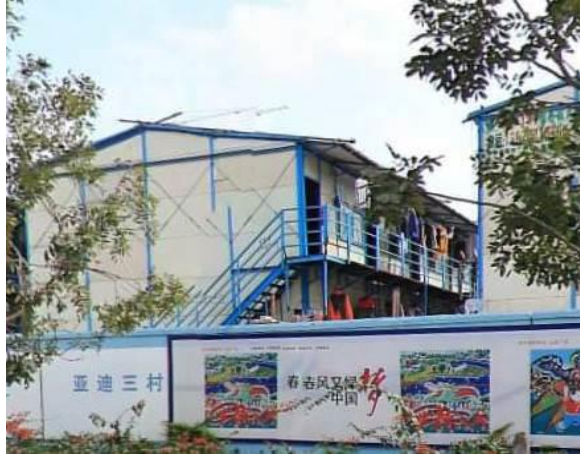
项目南面施工营地
