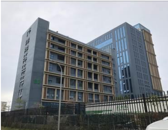
项目北面工业厂房
