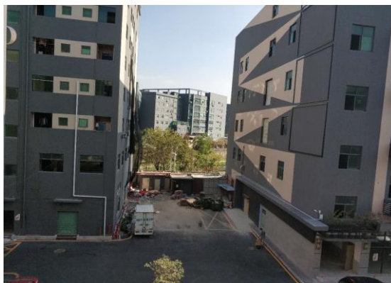
项目南面工业厂房
