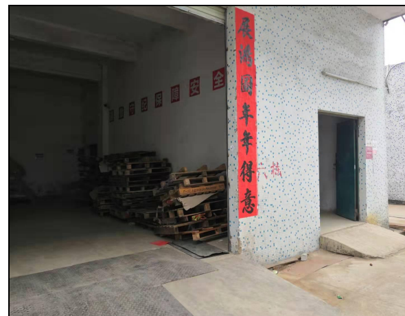
项目 7 栋车间现状
