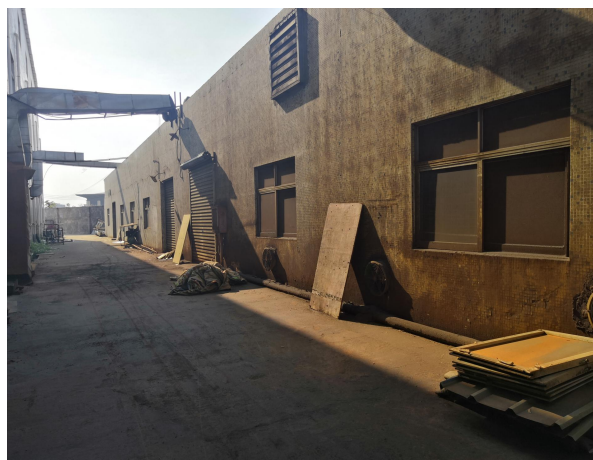
项目 7 栋北面工业厂房
