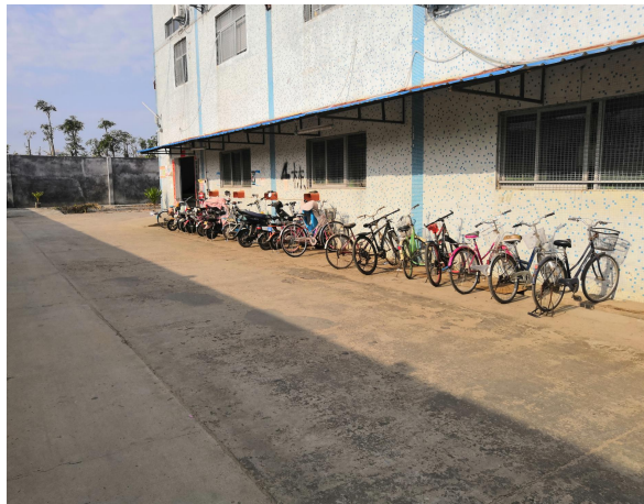
项目 4 栋所在厂房
