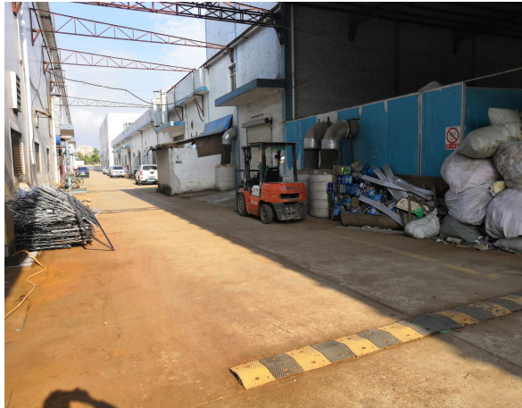
项目 4 栋南面工业厂房
