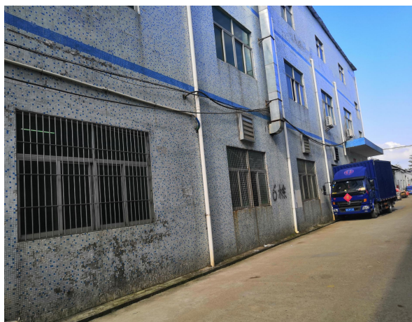
项目 7 栋所在厂房
