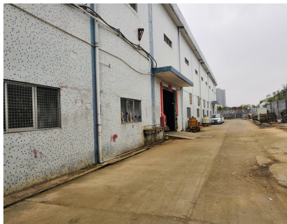
项目 7 栋南面工业厂房
