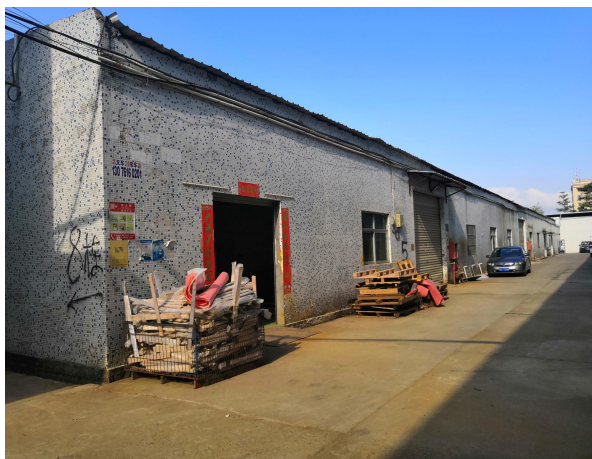
项目 7 栋东面工业厂房
