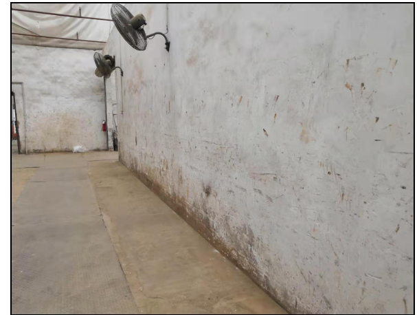
项目 4 栋车间现状
