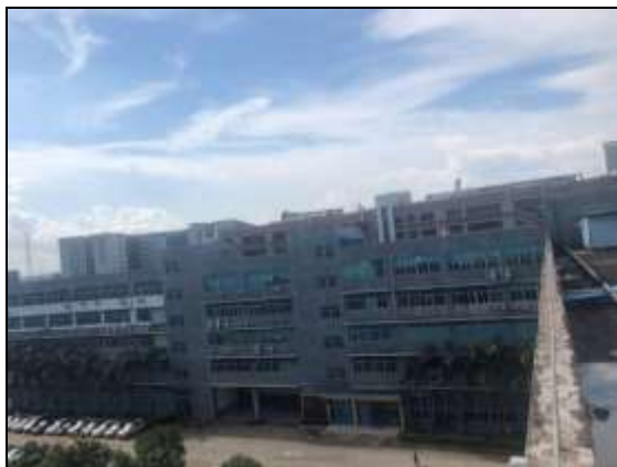
项目北面工业厂房
