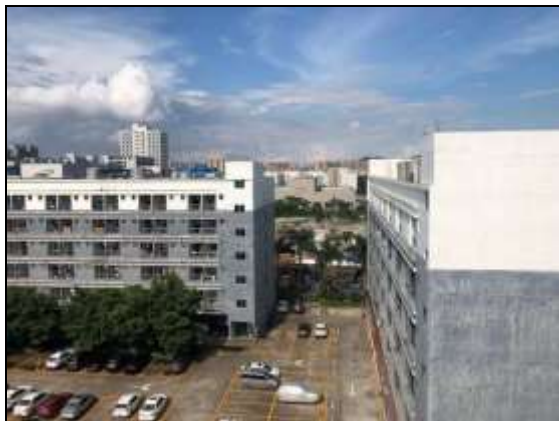
项目东面工业厂房
