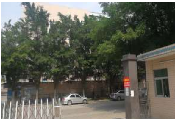
项目东面工业厂房
