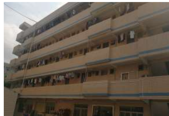
项目西面工人宿舍
