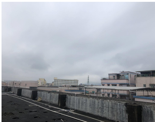
项目东面工业厂房
