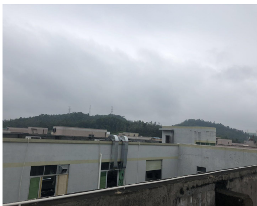
项目北面工业厂房
