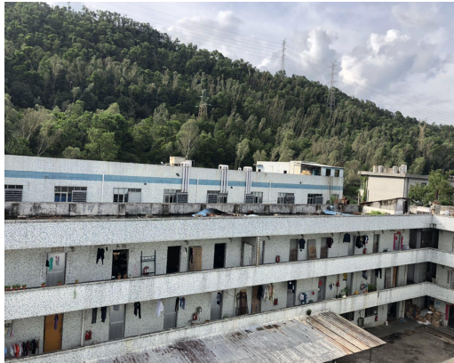
项目北面工业厂房
