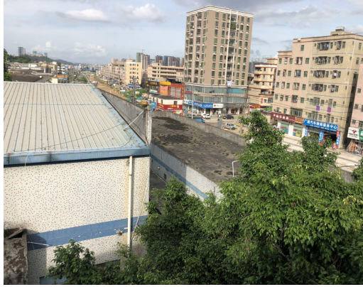
项目东面工业厂房
