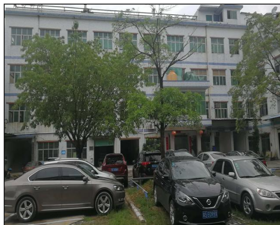
项目北面工业厂房
