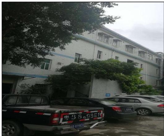
项目东面工业厂房
