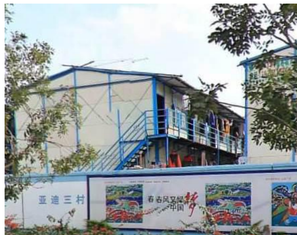
项目南面施工营地
