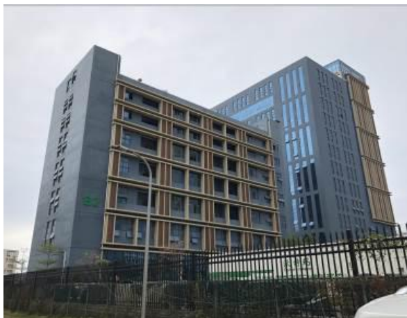
项目北面工业厂房
