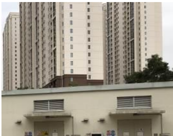
项目东面居民楼
