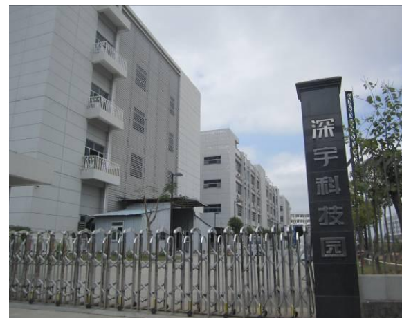
项目西面工业厂房
