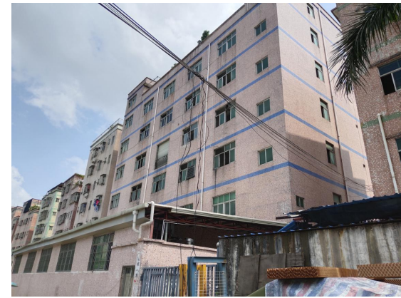
项目北面工业厂房
