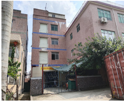
项目南面工业厂房
