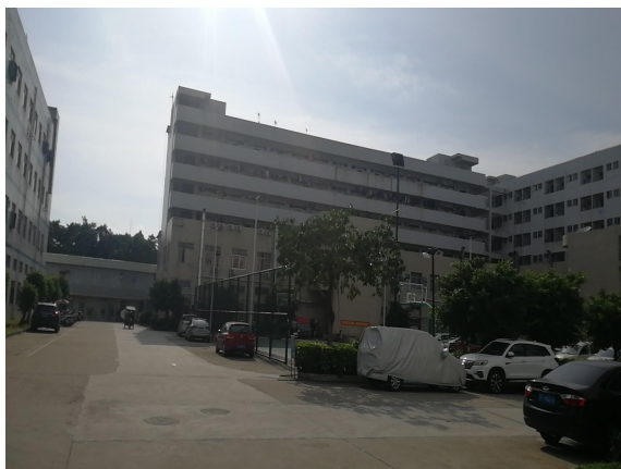
项目东面工业厂房
