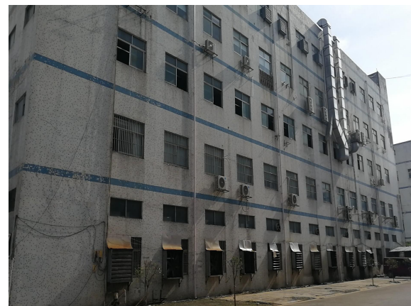
项目西面工业厂房
