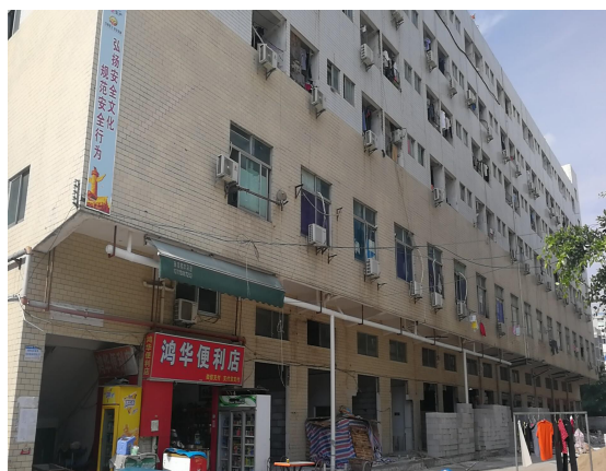
项目南面工业厂房
