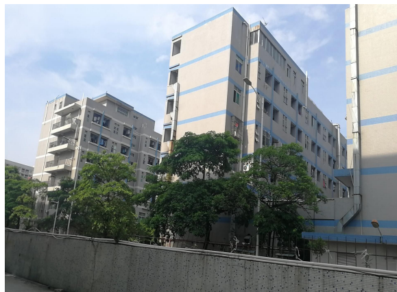
项目北面工业厂房
