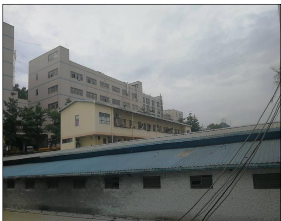
项目东面工业厂房
