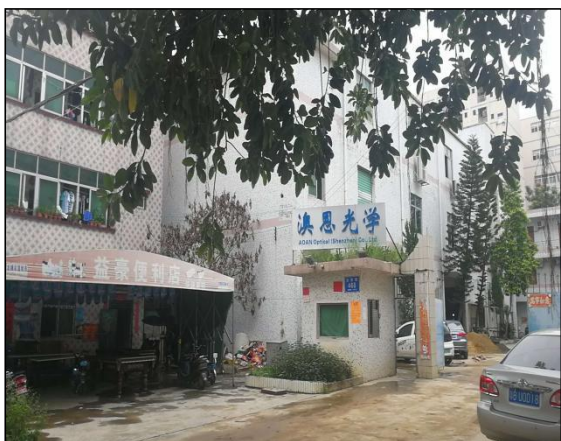
项目北面工业厂房
