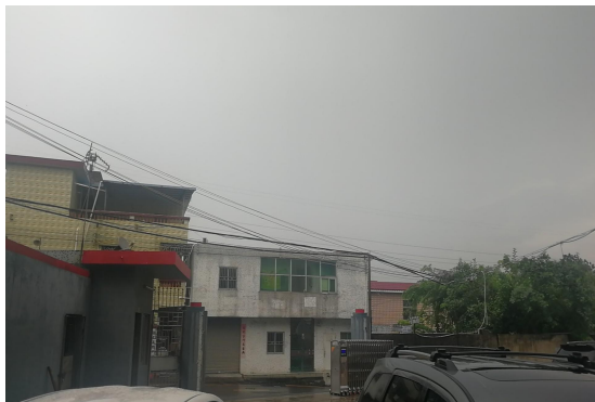
项目东面工业厂房
