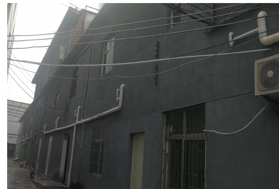
项目北面工业厂房
