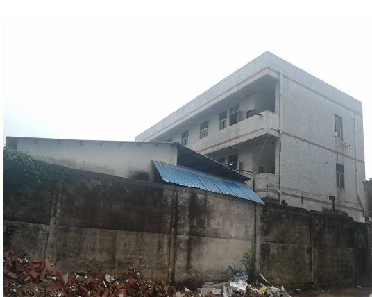
项目西面工业厂房
