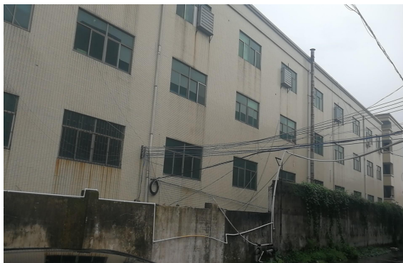
项目南面工业厂房
