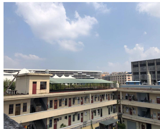
项目西面工业宿舍
