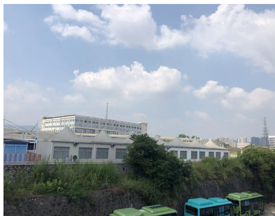
项目北面工业厂房
