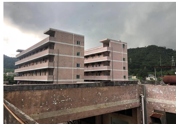
项目西面工业厂房
