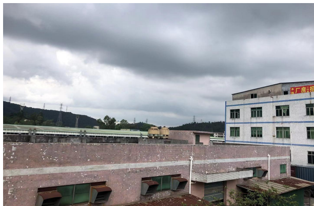
项目北面工业厂房
