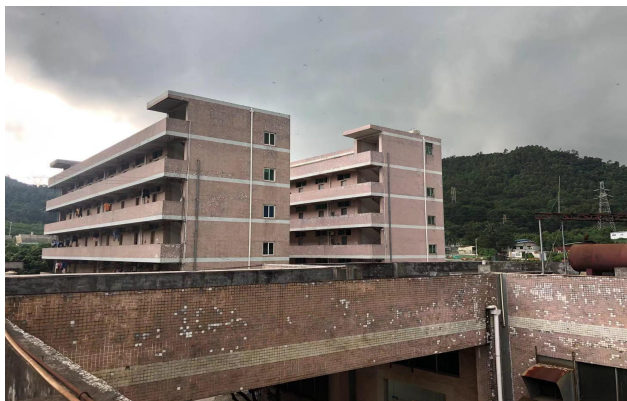
项目东面工业厂房
