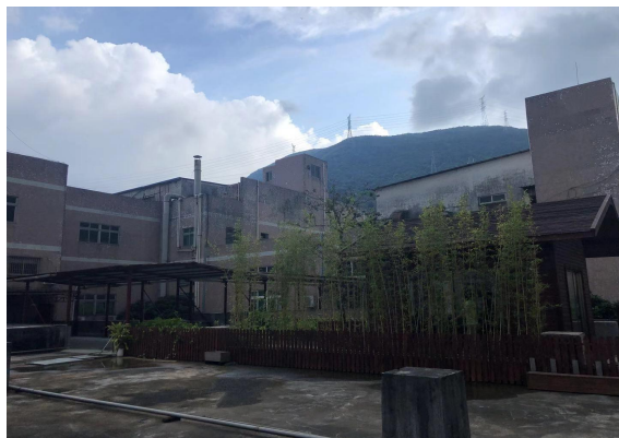
项目南面工业厂房
