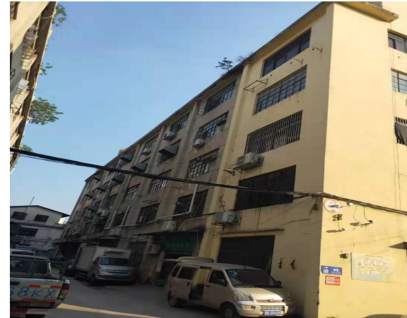
项目北面工业厂房
