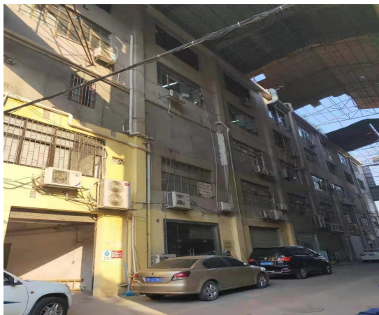
项目东面工业厂房
