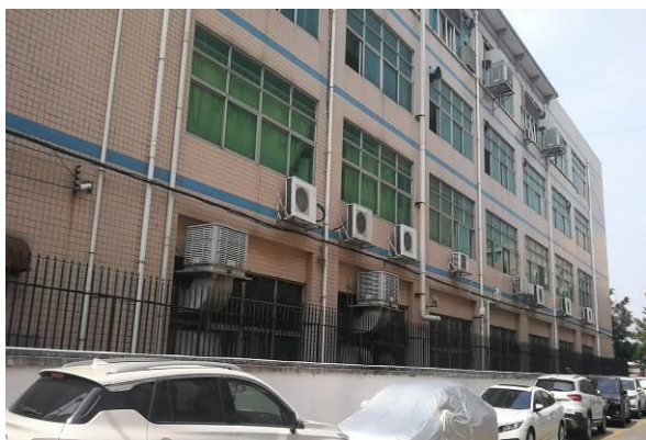
项目北面工人宿舍
