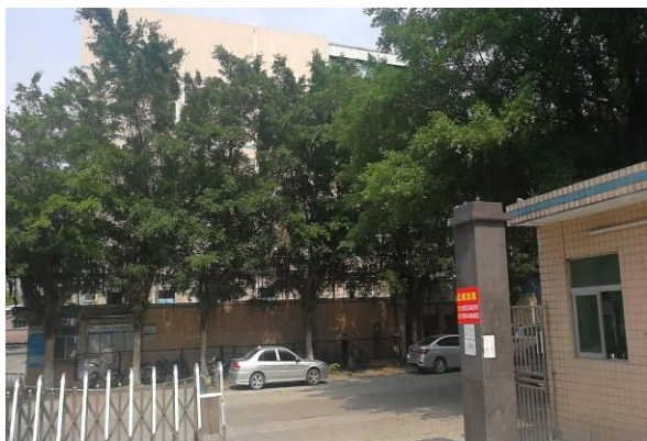
项目东面工业厂房
