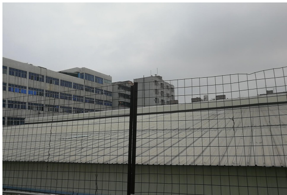
项目东面工业厂房
