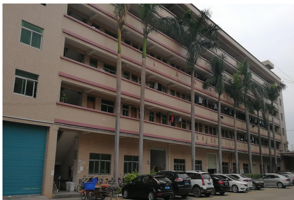
项目北面工人宿舍
