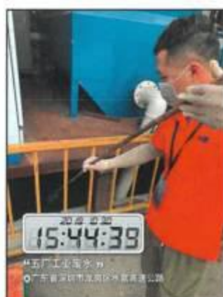
五厂污水处理池
