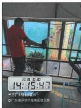
3 厂 1 号丝印废气检测口
