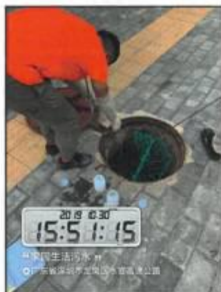
5厂生活污水排放口
