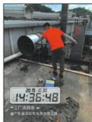
洗网房废气排放口
