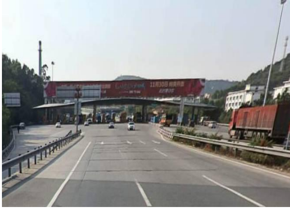
项目东面横坪路
