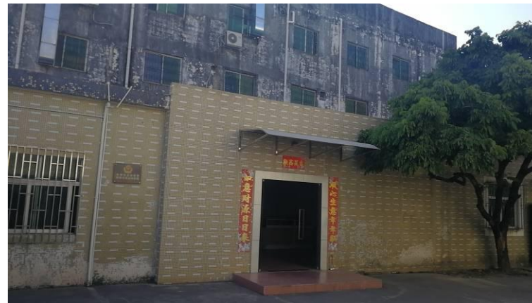
项目西南面工业厂房
