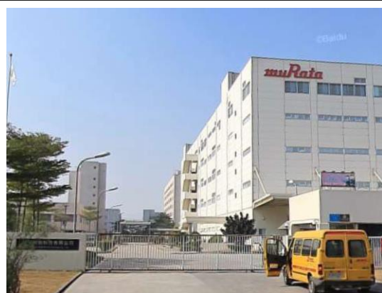
项目厂房现状
