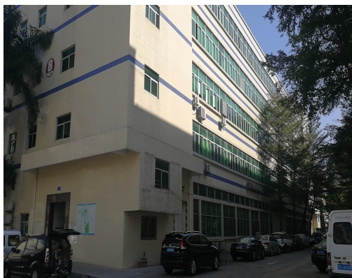
项目北面工业厂房
