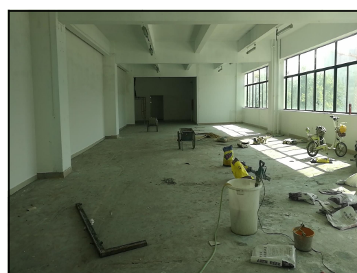
项目车间现状
