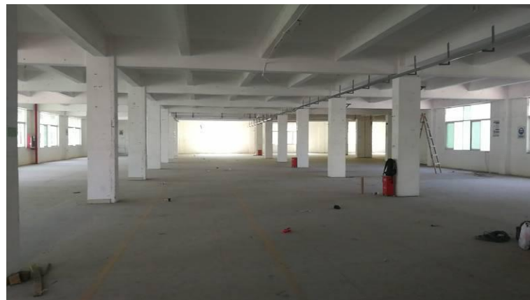
项目车间现状
