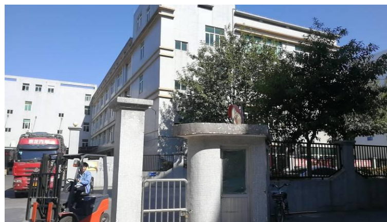
项目北面工业厂房
