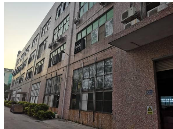
项目所在厂房外观现状
