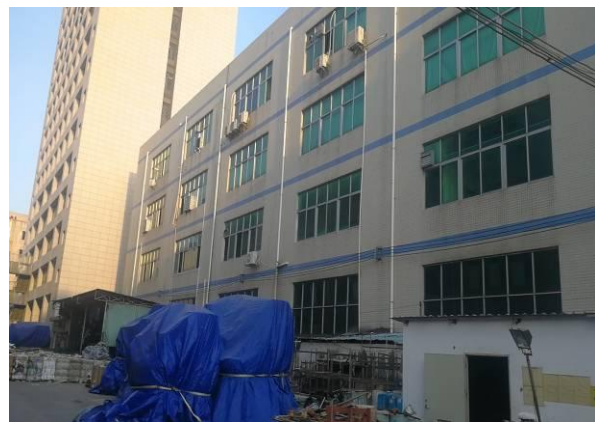
南侧 工业厂房及办公楼
