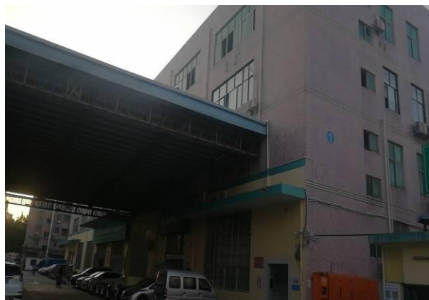
北侧相隔约 20m 的工业厂房（含社区服务中心）
