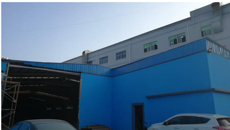
项目西南面工业厂房
