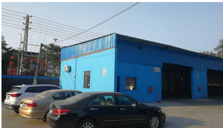
项目西北面工业厂房
