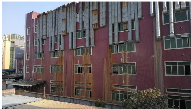
项目东南面工业厂房
