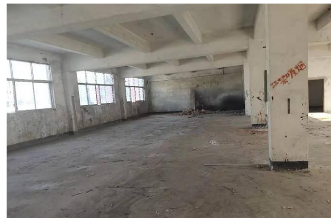
项目车间现状
