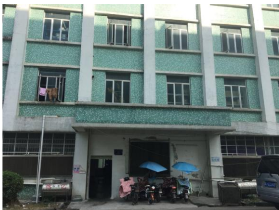
项目北面工业厂房
