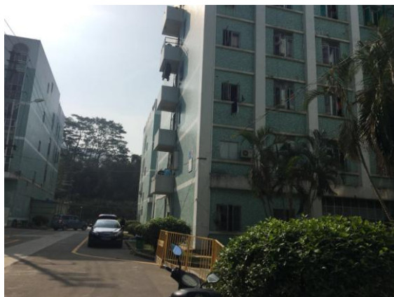
项目南面工人宿舍
