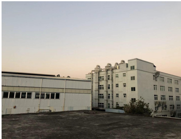
项目北面工业厂房
