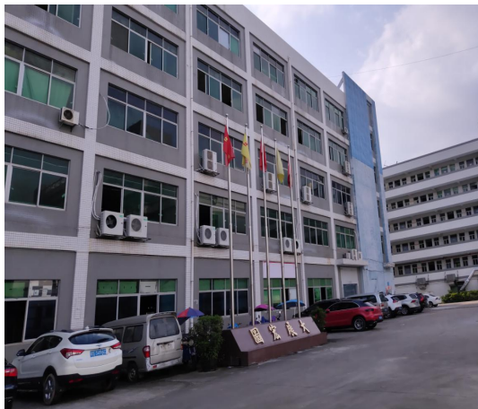
项目西面工业厂房
