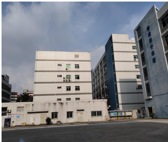
项目东面工业厂房
