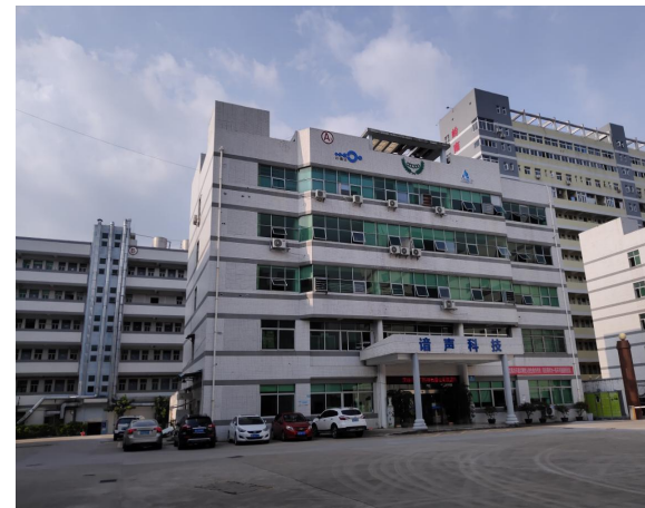
项目北面工业厂房
