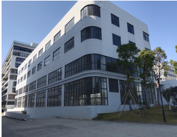
项目北面工业厂房
