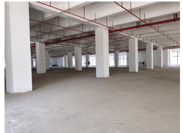
项目车间现状
