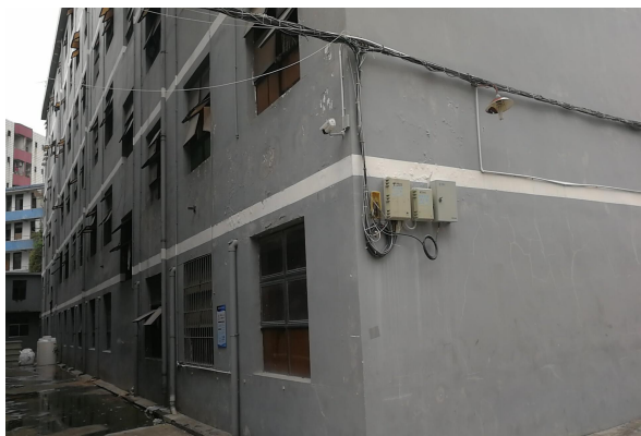
项目北面工业厂房
