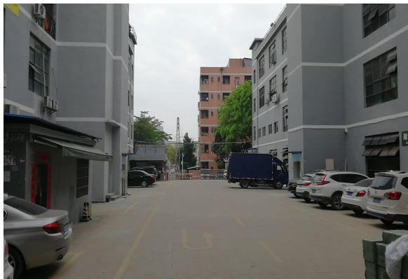
项目南面工业宿舍
