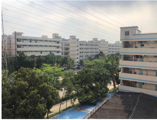
项目西南面临锦龙二路
