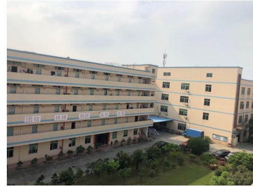
项目西北面相隔约35m宿舍楼及北面工业厂房
