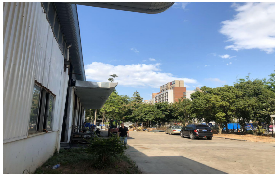
项目西面宿舍楼和空地
