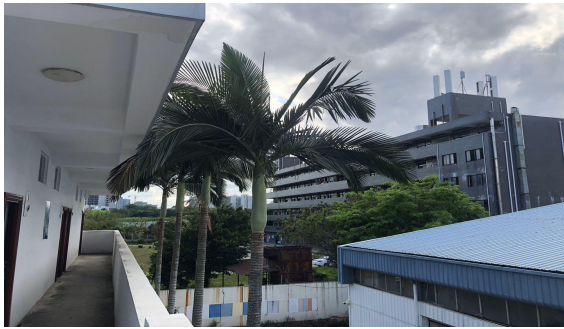
项目东面工业厂房
