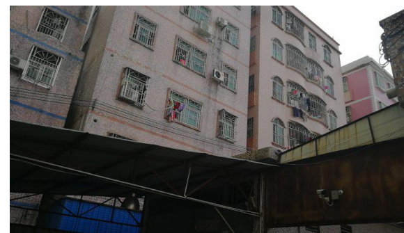
项目北面商住楼
