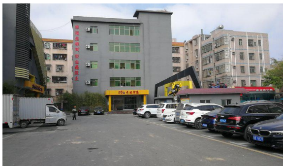
项目西北面工业厂房和停车场
