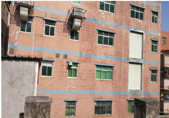
项目办公及宿舍楼
