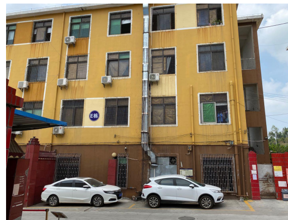
项目西面 11 号宿舍厂房
