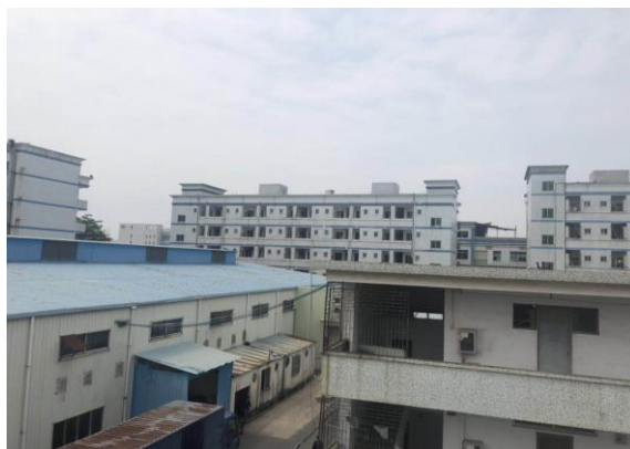
项目北面工业厂房及宿舍楼
