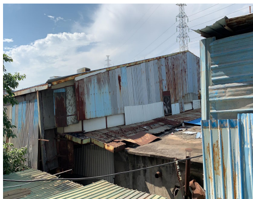
项目办公楼北面工业厂房
