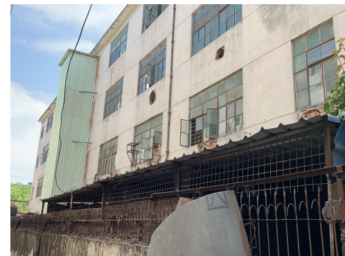
项目厂房西面工业厂房
