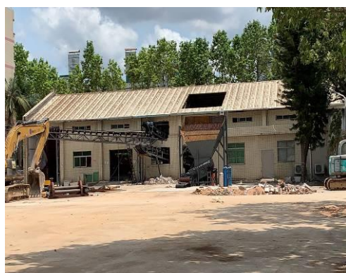
项目厂房外观现状
