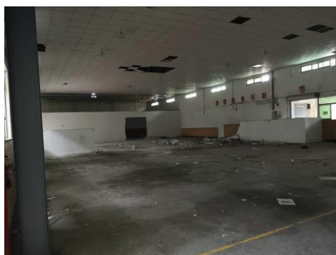
项目内车间现状
