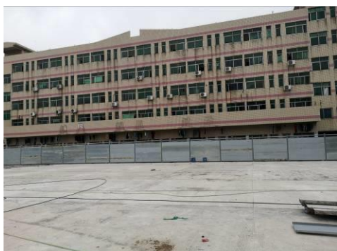
项目宿舍楼及办公楼
