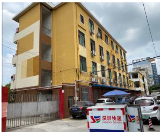
项目西面 13 号宿舍楼
